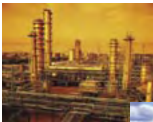
燕山石油化工
