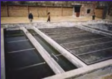
住宅の生活汚廃水を浄化して育苗の灌漑用水に利用(土壌浄化法)
