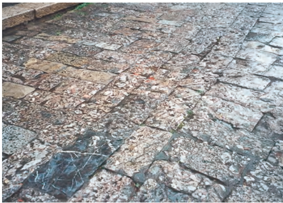
写真18 五彩花石を敷き詰めた道路
