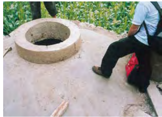
【写真62】 つま先の先に見えるメタンガスを取り出すための細い管
