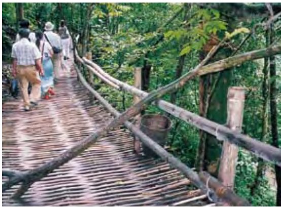
【写真27】 西双版纳原始森林公園の竹を編んだ空中遊歩道
