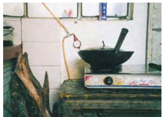
【写真79】レストランの調理場で見たバイオガスのパイプ
