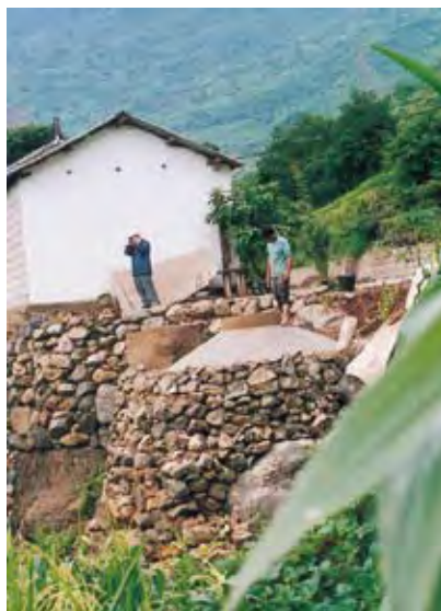
【写真61】 金沙江側から見上げた建設中のバイオガス発生施設
