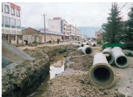
【写真94】土管を埋設中のシャングリラ市街地
