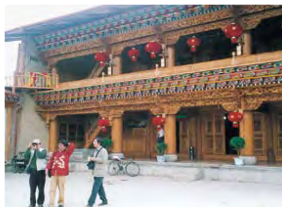
【写真87】 レストラン用に新築された蔵族の民家
