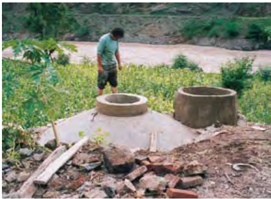
【写真60】 建設中のバイオガス発生施設
