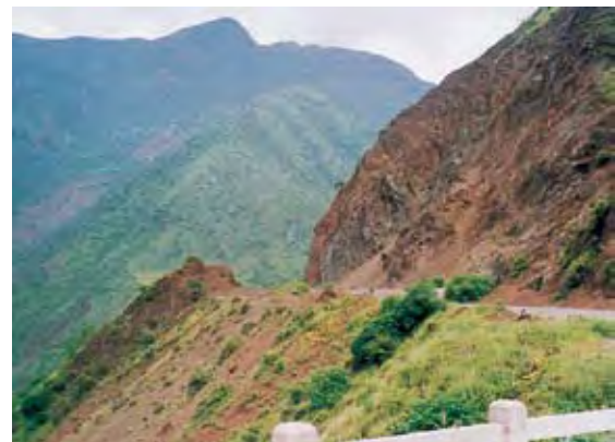
【写真63】 急斜面の山腹を彫りこんで造られた道路
