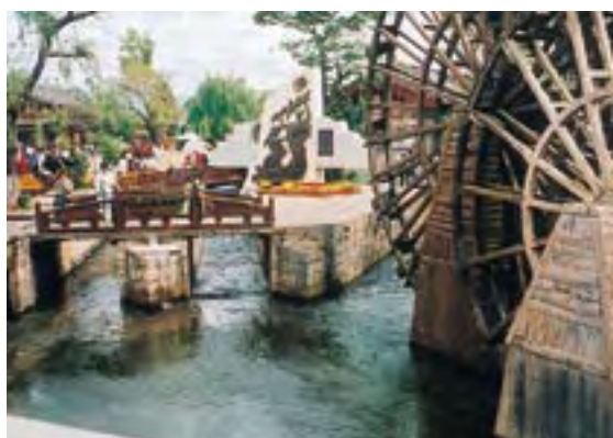
照片10 玉河广场的双联水车和分水堰 (面对照片从右至左依次为西河、中河、东河)
