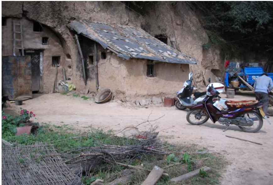
図 3-3 山門村土窯洞住宅
